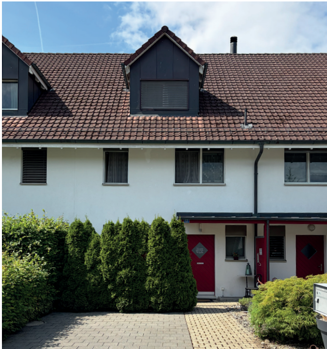
Eingangsbereich mit Vorplatz (Stellplatz für FZ)
